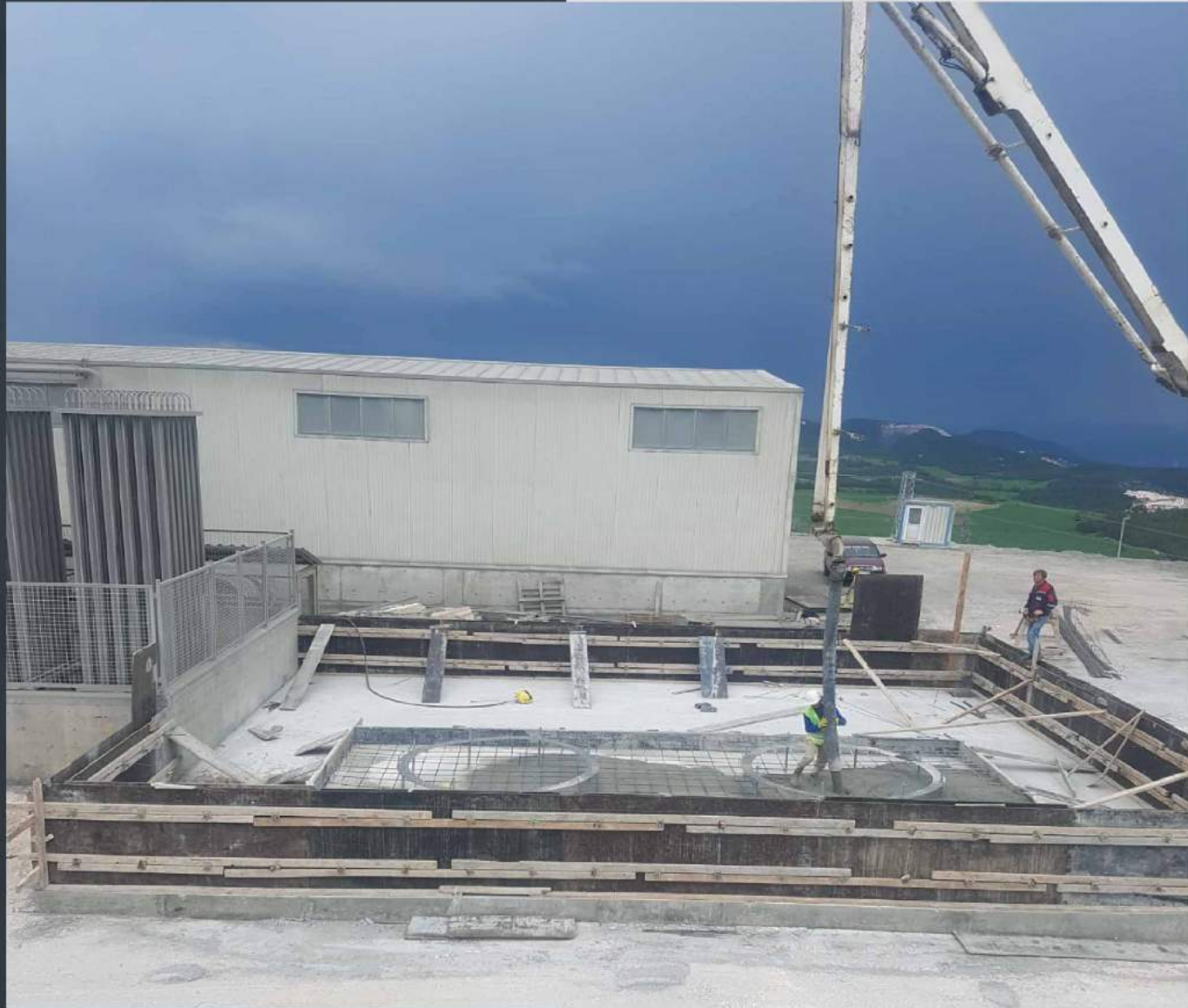
SANÇİM BİLECİK ÇİMENTO FABRİKASI LNG TANKI TEMELLERİ İNŞAAT İŞLERİ
